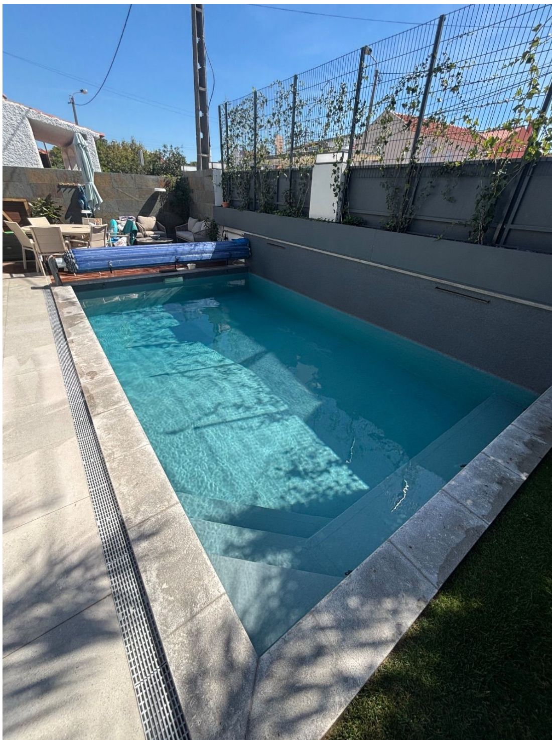
Общий вид бассейна
