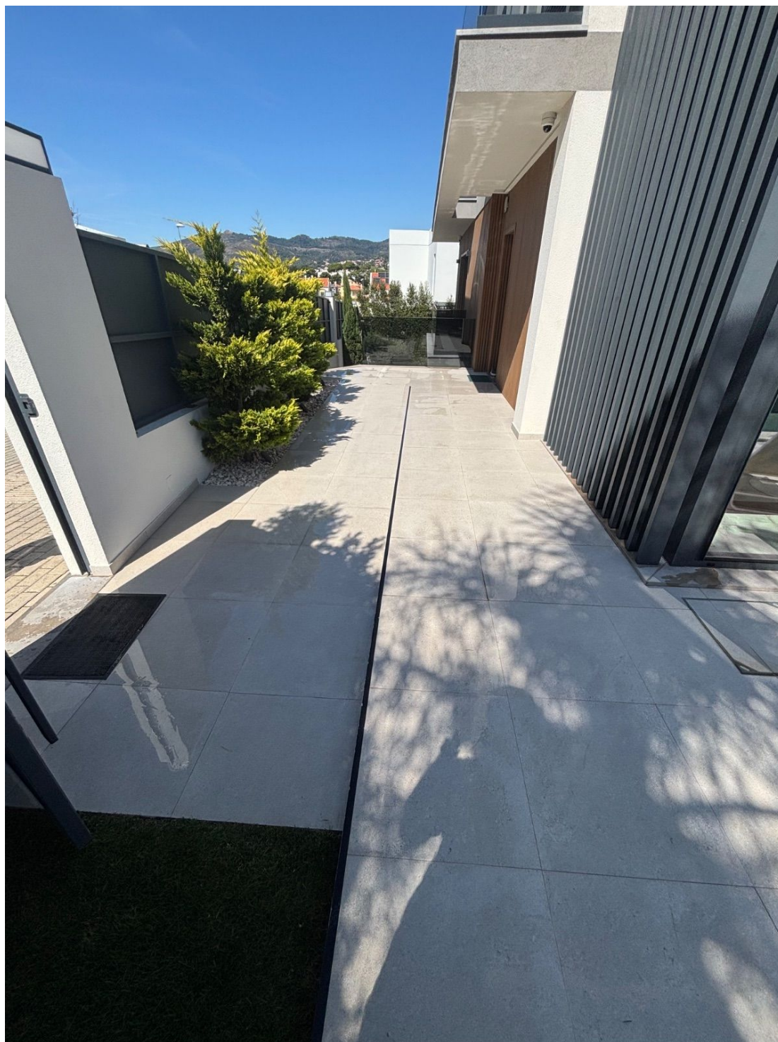
Pavimento exterior e drenagem
